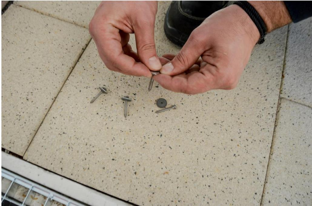
1. Die Schrauben werden nun durch das Netz des Insektenschutzgitters und der darunterliegenden Unterlegscheibe in die vorab eingeklappte Klammer verschraubt.
