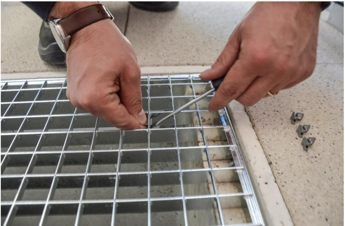
1. Das Befestigungsset enthält Metallklammern, die am Querstab von unten leicht angebracht werden können. Diese werden an 4 Punkten mit den gleichen Maschenabständen befestigt.
