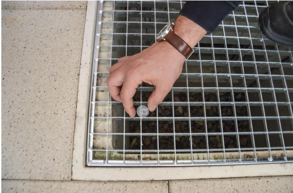
3. Das Insektenschutzgitter wird anschliessend vorsichtig mit dem Bürstenabschluss, der an der Wandseite angebracht ist, eng an die Hauswand angelegt und aufgedrückt. Der Bürstenabschluss verhindert den Eintritt von Insekten und Schmutz zwischen Hauswand und Abdeckung.
