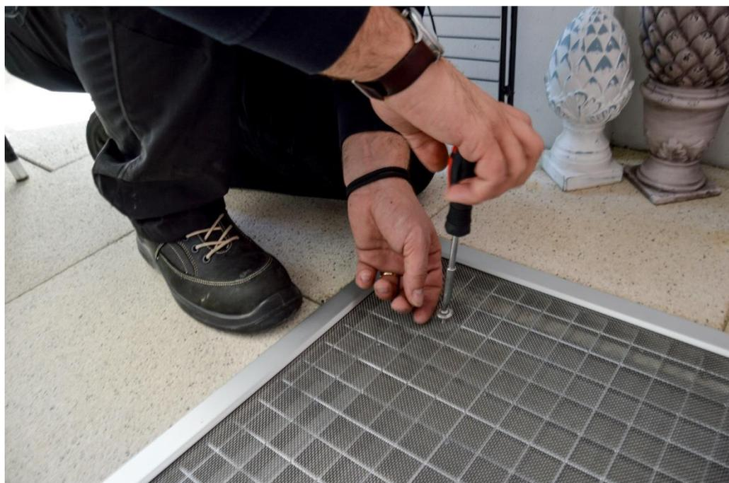
5. Die Lichtschachtabdeckung ist nun positioniert und fest montiert.
